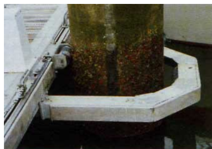
Figure 1 – Système d'amarrage des appontements
