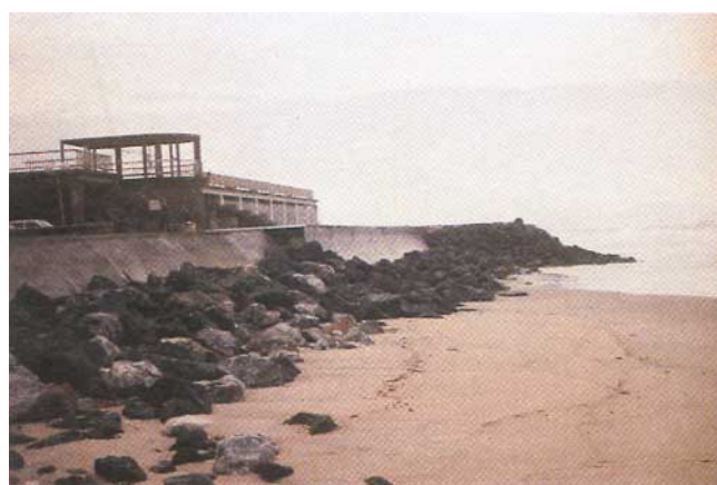
Figure 15 - Plage de Capbreton. Perré avec protection de pied en enrochements (profil d'hiver)
