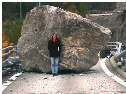
Figure 1 – Chute d'un bloc sur un tablier de pont à Moûtiers en 1998
