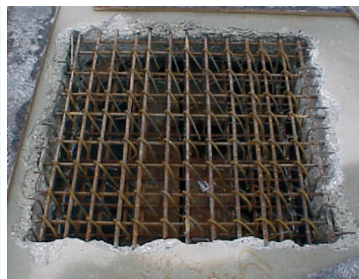
(b) armatures de la dalle après hydrodémolition
