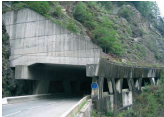
Figure 2 – Galerie pare-blocs de conception classique
