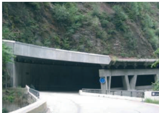
Figure 3 – Galerie pare-blocs structurellement dissipante des Essariaux dans le Val d'Arly en Savoie
