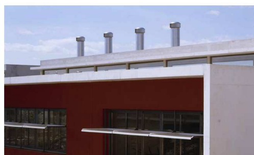
Tourelles d'évacuation de type Edmonds qui fonctionnent aussi bien par tirage thermique que par aspiration due à l'effet du vent.
