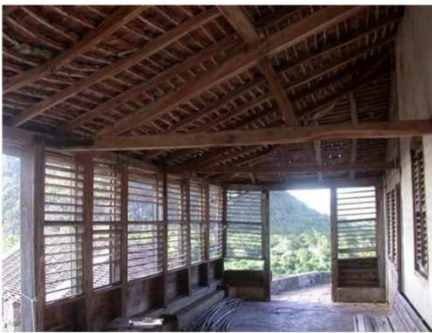
Maison de maître de l'habitation La Sucrerie aux Anses-d'Arlets (Martinique). Galerie persiennée pour conservée la ventilation tout en se protégeant d'avantage du soleil. Principe d'ouvertures intérieures permanentes ou mobiles pour une gestion de la ventilation traversante.
