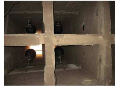
Récipients en terre poreuse disposés dans la tour à vent. http://www.richard-tolouie.com
