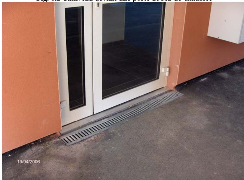
Fig. 6.2 Caniveau devant une porte de rez-de-chaussée
