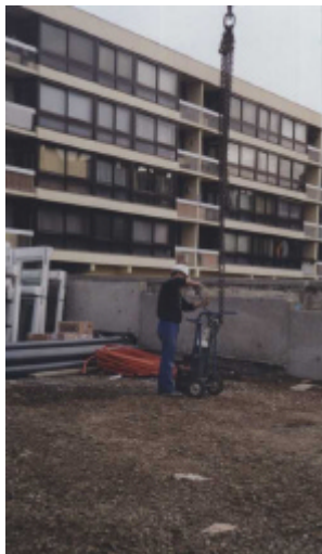
Transport à la grue des bonbonnes de gaz pour les plombiers
