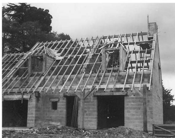
Vue n° 4 : charpente : pannes + chevrons Lucarnes à croupes pour l'éclairage des combles. Auvent sur piliers bois avec jambes de force en façade principale.
