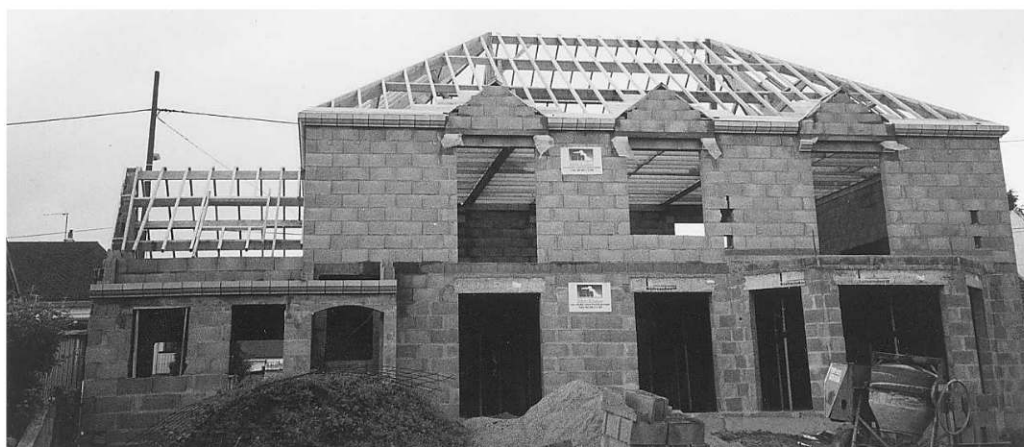
Vue n° 7 : toiture à croupes avec fermes classiques porteuses des pannes et chevrons À gauche, charpente avec pannes + chevrons et éclairage zénithal par vélux situé dans l'espacement de 2 pannes.
