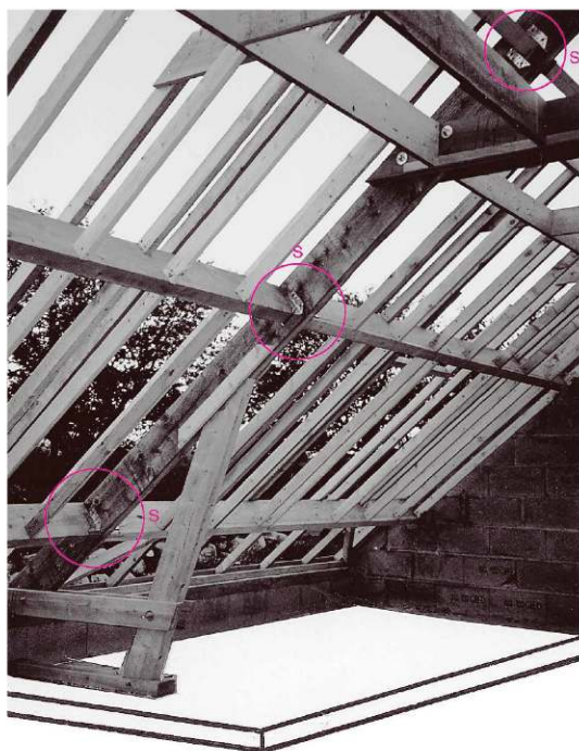
Vue 10 : Détails d'assemblages (sabots pour les pannes et boulonnage blochet-jambe de force)
