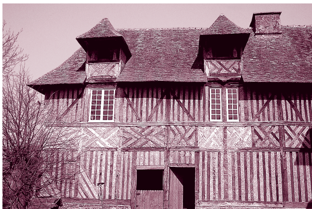
Décor recherché sur un bâtiment de ferme en pays d'Auge, avec doublement des branches des croix de Saint André marquant le niveau du plancher d'étage.
