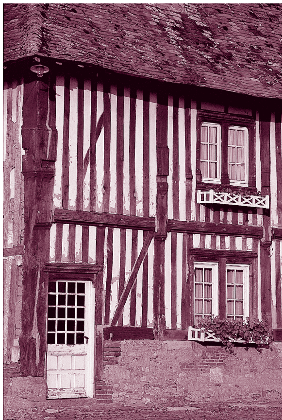
Détail de façade d'une maison du pays d'Auge, où les poteaux de remplissage forment une grille serrée, barrée d'éperons et de décharges.
