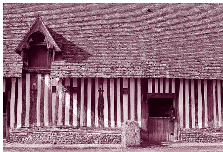
Bâtiment agricole en pays d'Auge, présentant une trame régulière, typique du pan de bois normand, avec colombes très rapprochées.
