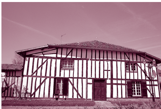
Maison du Perthois, en Champagne. Jeu régulier des poteaux, sablières et décharges. La façade est protégée par le débordement du toit formant demi croupe.
