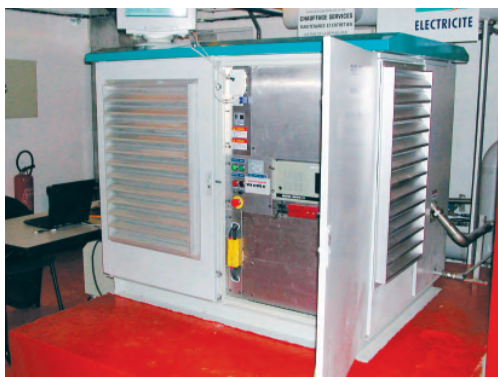
Pile à combustible sur site opérationnel, instrumentée dans le cadre du projet EPACOP
