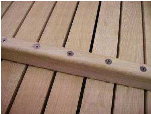
Vue du dessous de la fixation des lattes du plateau.
