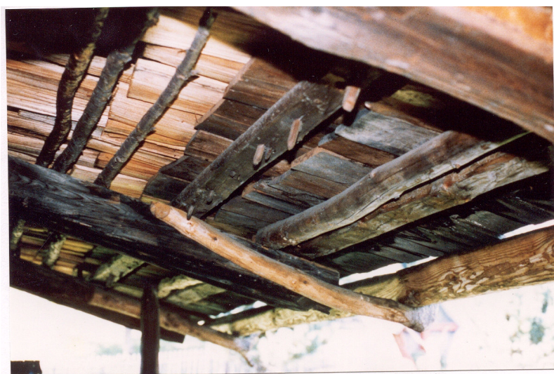
Photo 11 : la seconde rangée d'ancelles est chevillée pour mieux résister au vent en dépassée de couverture
