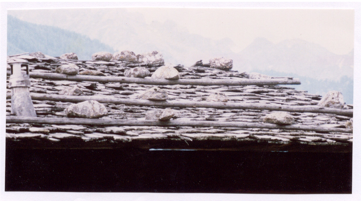
PHOTO 3) pierres et perches maintenant les ancelles en place
