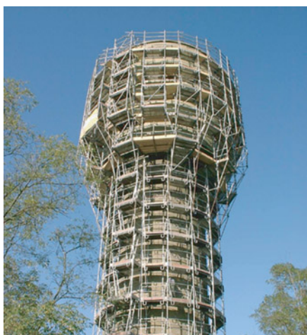
Figure 5 – Échafaudages pour château d'eau
