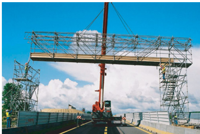
Figure 7 – Passerelles pour les chantiers
