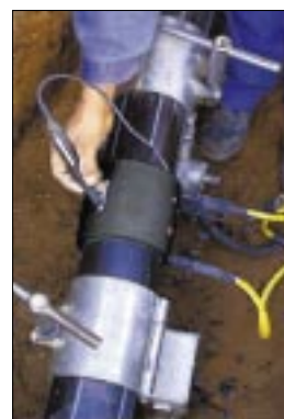
b) Électrosoudage sur PE
