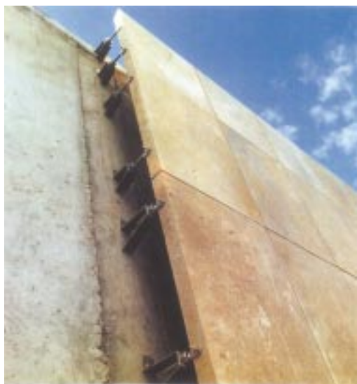
Figure 1 – Exemple de pose dans le joint vertical (doc. Rocamat)
