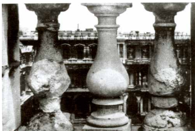
Figure 11 – Dégradation de la pierre par l'eau atmosphérique
