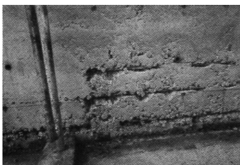
Figure 4 – Armatures mal enrobées lors du coulage du béton (le ragréage n'est qu'un mauvais remède)
