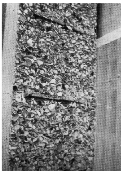
Figure 4 – Armatures mal enrobées lors du coulage du béton (le ragréage n'est qu'un mauvais remède)
