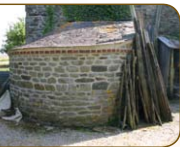
On retrouve régulièrement un bandeau de briques débordant de la maçonnerie sur les fours à pain du pays.
