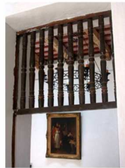
Maison de maître de l'habitation La Sucrerie aux Anses-d'Arlets (Martinique). Galerie persiennée pour conservée la ventilation tout en se protégeant d'avantage du soleil. Principe d'ouvertures intérieures permanentes ou mobiles pour une gestion de la ventilation traversante.
