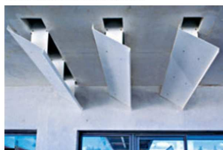
En sous-face des planchers, les pièges à vent sont constitués de lamelles en tôle d'aluminium qui captent l'air pour alimenter le cycle de ventilation.
