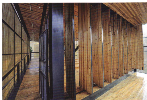
Parois pivotantes, fenêtres ouvrantes, latis et espaces fluides favorisent une ventilation naturelle dans un climat humide et chaud.
