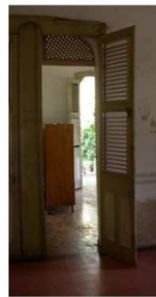
Maison de maître de l'habitation La Sucrerie aux Anses-d'Arlets (Martinique). Galerie persiennée pour conservée la ventilation tout en se protégeant d'avantage du soleil. Principe d'ouvertures intérieures permanentes ou mobiles pour une gestion de la ventilation traversante.
