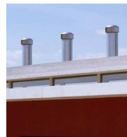
Combinaison d'une cheminée de tirage et d'une turbine éolienne. http://www.tribu-concevoirdurable.fr
