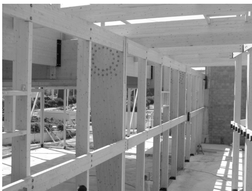
Photographie 3 : les boulons sont employés en charpente en bois lamellé-collé
