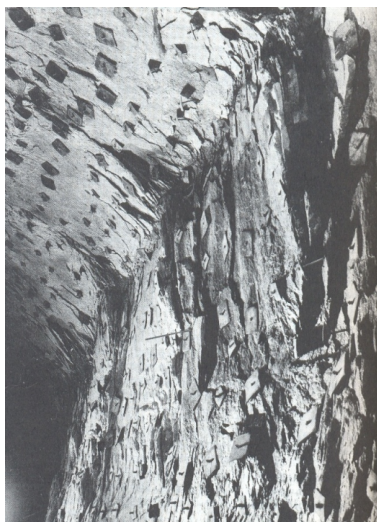
FIG. 1.12 – Ecaillage des parois du tunnel du Mont-Blanc lors de sa construction. Remarquer la forte densité de boulonnage.
