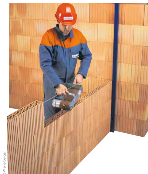
2 - Appliquez le mortier-joint au moyen d'un rouleau équipé d'une pige de réduction.
