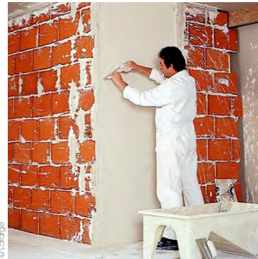
3 - Lorsque le plâtre commence à prendre, grattez-le avec une truelle ou une règle.
