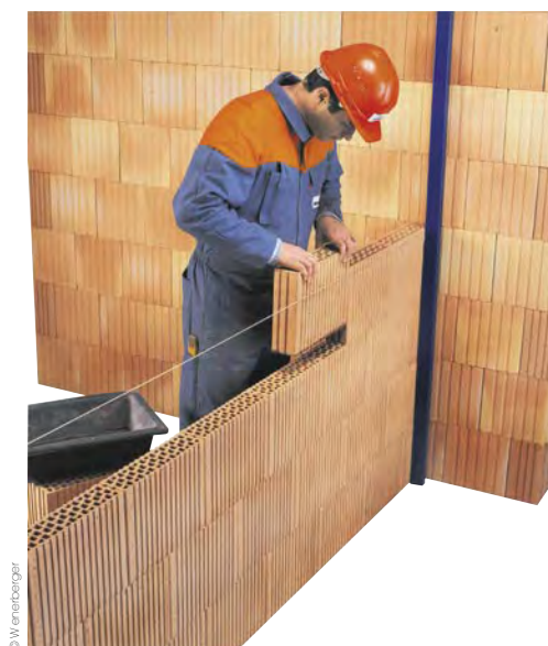
4 - Faites glisser chaque brique, en partant du haut de la dernière brique posée, jusqu'au mortier-colle.
