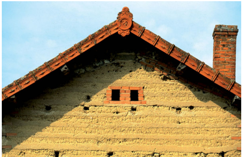
Maison en pisé du Lyonnais. La toiture présente un fort débord pour protéger les murs des intempéries.
