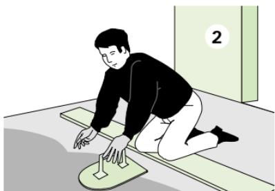
Le temps de séchage (de 2 à 4 heures) sera déterminé par l'épaisseur de l'enduit et la température ambiante. Attendre 24 h avant de poser le nouveau revêtement ou une deuxième couche.
