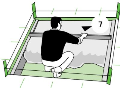
**7** Faire coulisser une grande règle métallique en suivant la pente créée par les chevrons parallèles pour lisser le sable en une couche bien rectiligne.
