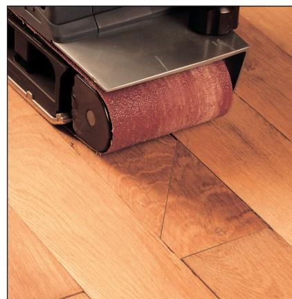
**8** Terminez la réparation en passant la ponceuse à bande jusqu'à rattraper exactement les niveaux. La reprise est pratiquement invisible, mais gardez à l'esprit que cet endroit a été fragilisé.
