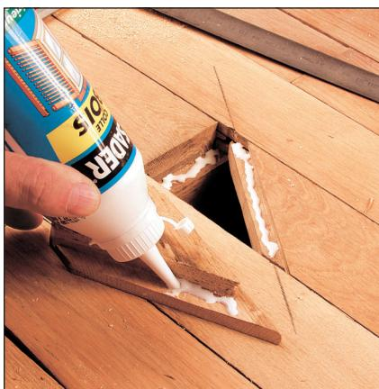
**7** Les surfaces de contact sont enduites de colle. Si votre réparation "boîte" un peu, vous pouvez sauver les apparences en remplaçant la colle à bois liquide par une qualité épaisse, type polyuréthane.
