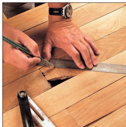
**1** Délimitez la zone à enlever par un trait de crayon en sifflet. Un angle à 45° est le minimum, bien pratique si l'on ne dispose que d'une boîte à onglet classique pour effectuer la réparation.
