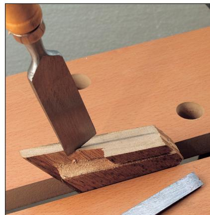
**6** Sur la pièce de réparation, et le long de la coupe en biais, dégarez une feuillure qui viendra reposer sur celle de la lame en place. L'extrémité opposée s'appuiera sur la lamourde et restera droite.
