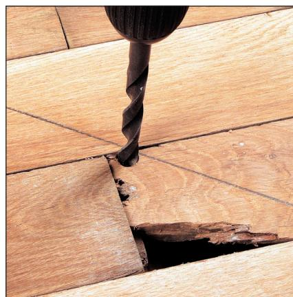
**2** Avec une mèche à bois de ø 10 mm, percez un avant-trou tangent au trait. Insérez la lame de scie sauteuse et coupez jusqu'au ras de la lame voisine. N'hésitez pas à confectionner un guide provisoire en clouant un tasseau parallèle au tracé, de manière à scier bien droit.
