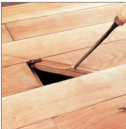
**3** À environ 1 cm du bord de la coupe, et parallèlement à celle-ci, dégarez une feuillure d'une profondeur réglée sur celle de la languette de la lame. S'il y a lieu, supprimez la languette d'extrémité.
