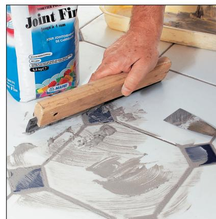
**8** Préparez le mortier de jointolement suivant les explications de la notice. Passez ensuite la raclette en caoutchouc en poussant sur le joint pour bien faire pénétrer la pâte au fond de la gorge.
