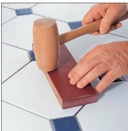
**7** Positionnez le carreau au centre. Ajustez-le à l'aide d'une cale en bois et d'un maillet pour écraser le lit de mortier-colle et mettre sa surface au même niveau que les carreaux voisins.
