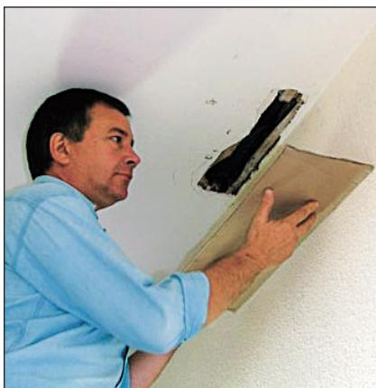
5 Présentez le carton chargé de plâtre sous l'ouverture à boucher. Appliquez des coups secs par-dessous, afin d'amener le plâtre à s'étaler. Il s'accrochera intimement aux bords de l'orifice.
