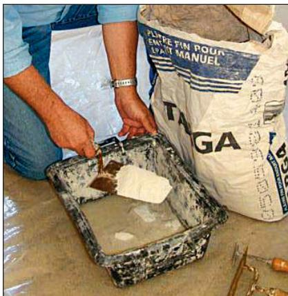
3 Versez d'abord de l'eau dans une auge, puis épandez le plâtre en pluie par des mouvements vifs de la truelle. Pour un litre d'eau, comptez environ quatre à cinq truelles de plâtre.
