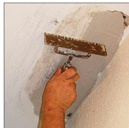
8 La Berthelée est utilisée, côté denté, pour ôter l'excédent de plâtre en se réglant sur le plafond. La finition se réalise avec le côté lisse. Après séchage, une passe d'enduit rendra la réparation invisible.
