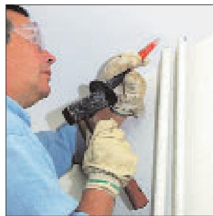
**1** Avant de creuser, protégez vos yeux et vos mains. Avec un plafond sur lattis de bois ou en plaques de plâtre, il est possible d'utiliser une scie sauteuse pour ménager l'ouverture.
