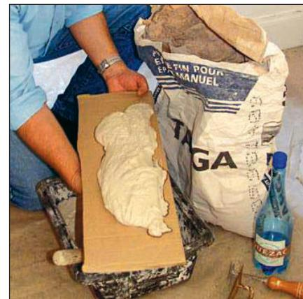
4 Parvenu à la consistance désirée, déposez le plâtre sur le carton, moulé aux dimensions de l'ouverture à reboucher. Étagez la charge en hauteur, plutôt qu'à plat : elle se répartira mieux.
