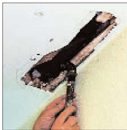
**2** Des tuyaux de chauffage "tarabiscotés" peuvent créer la (mauvaise) surprise en obligeant à agrandir démesurément le trou pour les extraire. Ne vous laissez pas impressionner !
