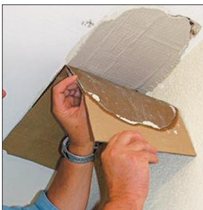
7 Pendant le temps nécessaire à la réparation et à la prise du plâtre, le support cartonné s'est chargé d'humidité. Il s'enlève sans aucune difficulté, comme la pelure d'un fruit.
