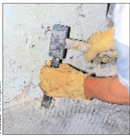
**1** Pour installer la prise de terre à l'aplomb du tableau d'alimentation, réalisez un trou de Ø 80 mm dans la dalle de béton. Percez plusieurs trous en périphérie, avant d'achever le travail au burin.
