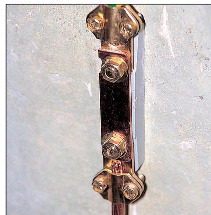
**6** *Serrez la tresse reliée au piquet, puis le câble supérieur isolé vert-jaune en 16 mm<sup>2</sup> connecté à la borne terre du tableau. La barrette centrale s'enlève pour mesurer la résistance de la prise de terre.*
