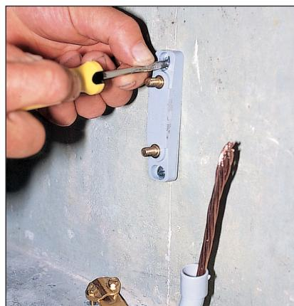
**5** *Démontez le dispositif de coupure pour fixer sans gêne son socle au mur. Passez la tresse en cuivre nu dans une gaine en PVC que vous coudez pour compenser le décroché du mur.*
