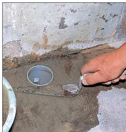
**3** *Lorsque le piquet est complètement enfoncé, scellez au mortier une chute de tube PVC Ø 80-100 mm. Elle constitue une protection de la tresse de sortie et un puits pour humidifier le sol.*
