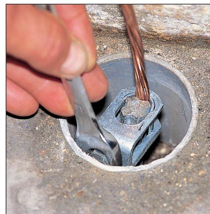
**4** *Engagez la tresse de sortie, de section 25 mm<sup>2</sup>, dans l'une des cannelures ménagées au sommet du piquet. Ceinturez le tout avec un collier métallique et serrez bien la vis de pression pour optimiser le contact.*
