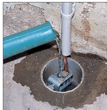
**8** *La prise de terre est d'autant plus efficace que le sol est humide. De temps à autre, versez de l'eau dans le puits pour rendre le sol plus conducteur et diminuer la résistance.*
