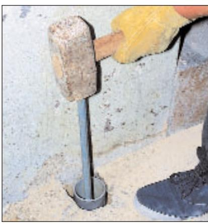
**2** Enfoncez le piquet spécial en fer galvanisé au centre du trou à l'aide d'une grosse masse. Contrôlez fréquemment la verticalité de sa descente, une pierre fichée dans le sol pouvant le faire dévier.
