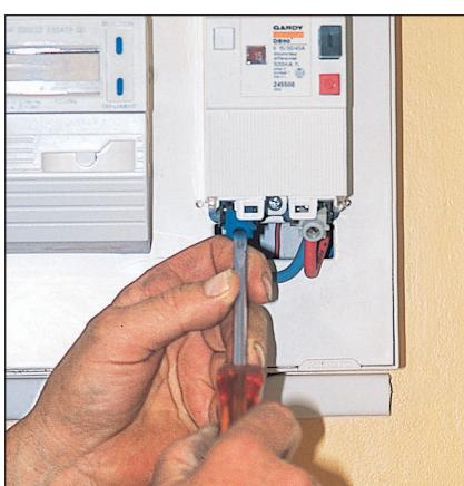
7 Courant toujours coupé, connectez sur la sortie du disjoncteur de branchement les deux fils de 10 mm<sup>2</sup> laissés en attente, provenant de l'entrée du différentiel. Attention à la polarité !
