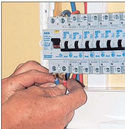
3 Clipsez à leur tour les divisionnaires sur le rail. Avec du fil de 10 mm<sup>2</sup>, connectez l'entrée du différentiel et laissez-le en attente à l'arrière. Branchez en sortie deux brins de même section.
