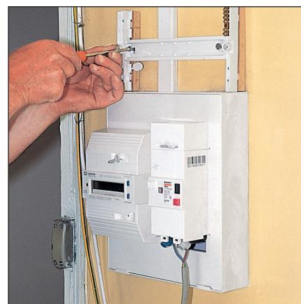
**1** Placez le support de modules à proximité du coffret EDF. Après perçage du mur et chevillage, vissez le bâti en deux points en plaçant des cales de compensation en bois sous les pattes.
