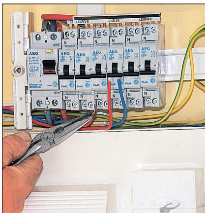
5 Reliez les fils de phase et le neutre de chaque circuit d'utilisation aux sorties des divisionnaires. Regroupez les différents conducteurs de terre sur le bornier spécial. Serrez bien les vis.
