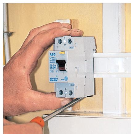
**2** Sur le rail, clipsez l'interrupteur différentiel de sensibilité 30 mA en actionnant sa languette au tournevis. Il est destiné à protéger les personnes et disjoncte en cas de courant de fuite.
