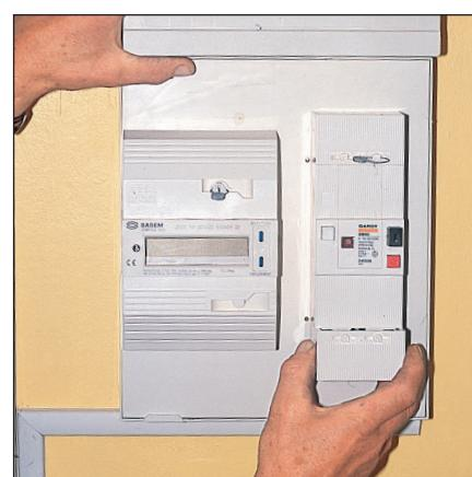
8 Remontez et verrouillez les capots du disjoncteur général et du tableau. Les éléments modulaires s'inscrivent dans la fenêtre et des caches sont prévus pour les places inoccupées.
