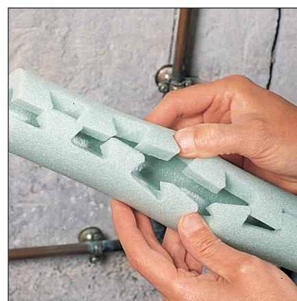
**1** Pour mettre en place un manchon en PELD vert, séparez d'abord ses bords crénelés afin de pouvoir le glisser derrière le tuyau. Enrobez bien ce dernier, puis rapprochez les encoches à queues-d'arondie pour les remboîter. Ce système d'assemblage se suffisant à lui-même, nul besoin de bande adhésive pour renforcer la jonction.
