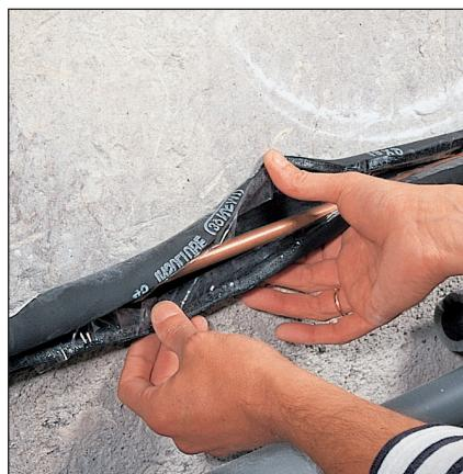
**2** Posez de la même façon le manchon en caoutchouc, en veillant à ne pas décoller la bande qui protège l'adhésif garnissant l'un des bords. Faute de quoi, ils risqueraient de se coller l'un sur l'autre.
