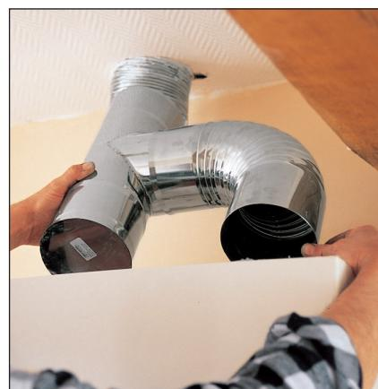
**5** Le raccordement entre le flexible et la chaudière s'effectue au moyen d'un té fermé par un tampon. Les éléments sont simplement emboîtés les uns sur les autres, sans collier de fixation et demeurent ainsi facilement démontables.
