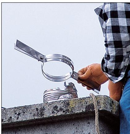
**2** Un collier de fixation est serré sur le tube, 5 cm sous son extrémité pour permettre le montage du couronnement. Il est fixé sur les bords du conduit existant. Si celui-ci le justifie, une plaque d'étanchéité est enfilée sur le tube.
