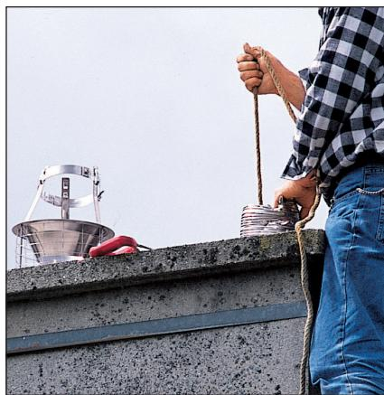
**1** Pour faciliter le doublage d'un conduit (ici un tube flexible simple peau en aluminium) voici une astuce. Adaptez une fixation démontable (fil de fer, pince...) à l'extrémité du tube. Enfilez une cordelette lestée pour lui permettre de descendre dans le conduit. Puis attachez-la à la fixation accrochée à l'intérieur du tube et hissez l'ensemble vers le haut. Une seconde personne, placée en dessous du conduit, peut aider au passage du tube.
