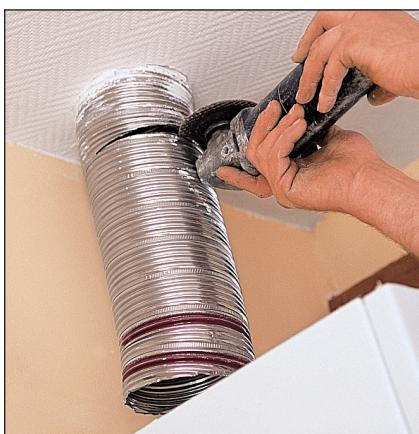
**4** En partie basse, le tube est maintenu par un collier de fixation monté sur le mur avant la finition du plafond au plâtre. Le flexible est coupé au moyen d'une meuleuse afin d'obtenir une section nette, sans déformer le tube.
