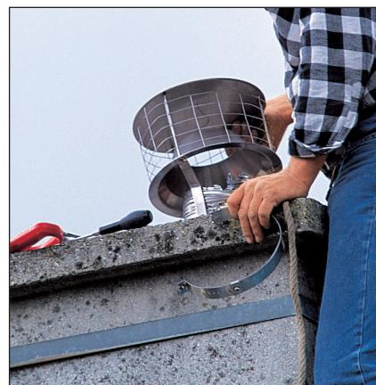
**3** Le chapeau pare-pluie est monté à l'extrémité du tube. Sa grille empêche les oiseaux de nicher. Si le conduit existant dispose déjà d'un couronnement (une cape à l'italienne, par exemple), le chapeau est inutile.
