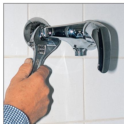
**8** Le montage final se fait après la pose du carrelage. Vissez les rosaces sur les excentriques. Placez dans leur entrée les manchons réducteurs. Posez les joints plats en fibre et serrez les douilles du mitigeur.
