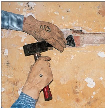
**3** Ce mur va constituer un panneau de la douche. Derrière la cloison se trouvent les canalisations d'alimentation générale. Pour les raccorder, tracez l'emplacement du mitigeur et creusez une saignée avec un burin plat et une massette.
