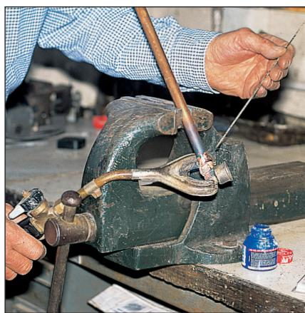
**1** Utilisez un flux décapant adapté au métal d'apport. Avec un chalumeau propane équipé d'un brûleur de type Cercocflam (qui concentre ses flammes sur le tuyau), soudez un raccord (pipe) en bout du tuyau.
