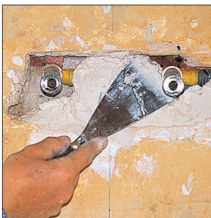
**5** Placez provisoirement les deux excentriques sur les raccords coudés pour éviter de boucher les tuyaux. Scellez au plâtre en bourrant la cavité murale. L'entrée des raccords ne doit pas dépasser le plan du mur.
