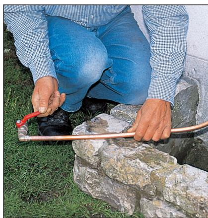
**2** Les soudures des deux canalisations doivent être parfaitement étanches. Pour les tester, fermez le raccord par une vanne à sphère et raccordez son autre extrémité à un tuyau d'arrosage mis sous pression.
