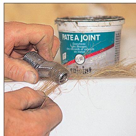
**6** Les excentriques sont des raccords mâle-mâle. Ils permettent d'adapter avec exactitude l'écartement des raccords à l'entraxe du mitigeur. Appliquez de la pâte à joint sur le filetage, puis enroulez quelques brins de filasse. Lissez.
