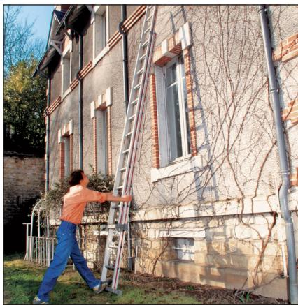
**1** Les échelles se transportent sur chant jusqu'à l'endroit où elles doivent être redressées, puis mises en appui. Attention au ballant créé par le déplacement rapide du centre de gravité.
