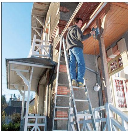
**7** En position ouverte, cette échelle "à la parisienne" n'a pas besoin d'un mur d'appui. Mais la prudence reste de mise puisque la stabilité latérale diminue à mesure que l'on gravit les échelons.
