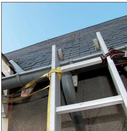
**5** Sur des surfaces lisses comme les gouttières en zinc, il est impératif d'arrimer le haut des montants à un point solide : une console ou l'extrémité d'un chevron par exemple.
