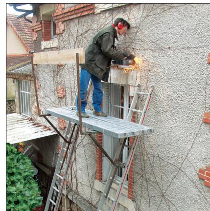
**8** Pour travailler à deux mains, il est possible de monter un praticable avec deux échelles réunies par des planches fixées sur consoles spéciales. Le plancher doit être solide (demi-bastaings minimum).
