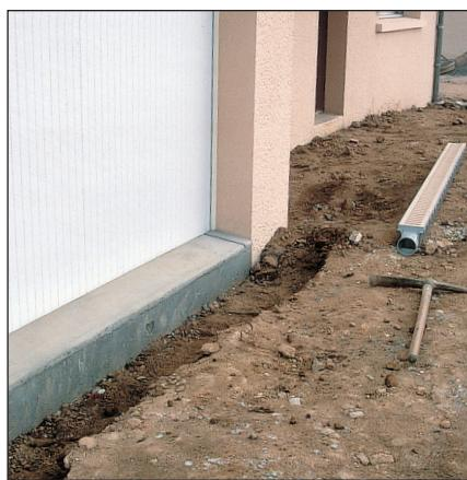
**1** Délimitez l'emplacement du caniveau avec des cordeaux et des piquets ou tracez au plâtre. Creusez une tranchée plus large de 10 cm et plus profonde de 5 cm que les dimensions du profilé.
