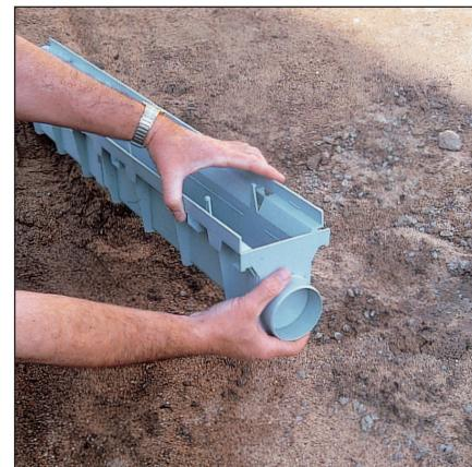
**4** Dégarez le fond s'il doit recevoir une descente d'eaux pluviales. Clipsez-le sur l'élément de départ. Si ce dernier a été scié, le fond s'emboîte et se bloque dans la tranchée.
