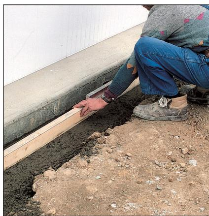
**2** Coulez une semelle de béton maigre (250 kg/m<sup>3</sup>) sur 5 cm d'épaisseur en fond de tranchée. Ajustez le niveau à la règle métallique pour lui donner une légère pente (5 mm/m) vers l'aval.
