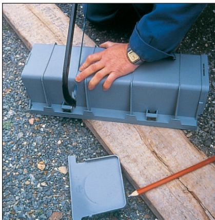
**3** Posez à blanc les éléments du caniveau en PVC renforcé sans les grilles. Si nécessaire, découpez à la scie à métaux l'élément de départ pour ajuster sa longueur. Veillez à scier entre les renforts.
