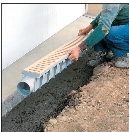
**7** Les éléments du caniveau forment une poutre rigide facile à déposer dans la tranchée. Pour de grandes longueurs, procédez en plusieurs fois. Raccordez la naissance au réseau d'évacuation.
