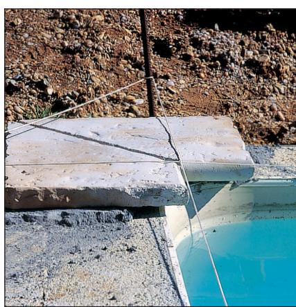
1 Gâchez un mortier de consistance assez épaisse. Dans les angles, déposez une assise de 3 cm d'épaisseur, large et plane. Posez les deux dalles, et stabilisez-les sur leur lit.
