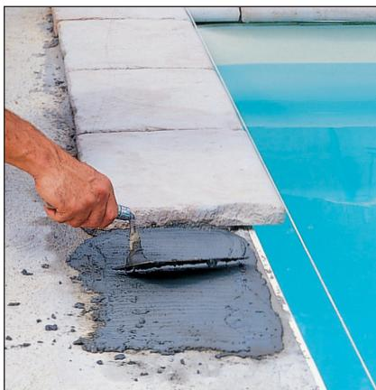
**5** Évitez d'étendre le lit de mortier jusqu'au rebord de la piscine. Sous la pression, il risque de refluer vers le bassin. En revanche, soyez généreux au centre et à l'arrière.
