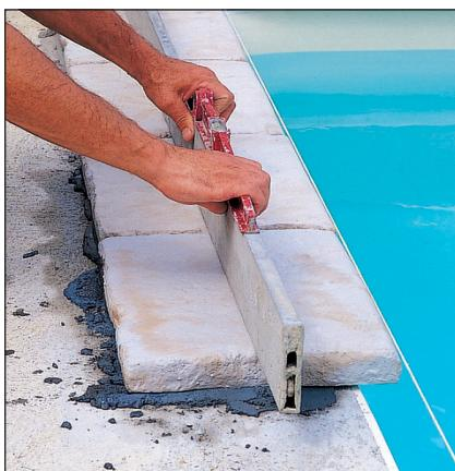
**7** À l'aide d'une règle de maçon surmontée d'un niveau à bulles, contrôlez régulièrement la planéité. Si nécessaire, utilisez un maillet en caoutchouc pour rattraper les défauts.
