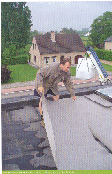
Pose de la couche de drainage sur la couche d'étanchéité avant la mise en place du substrat.
