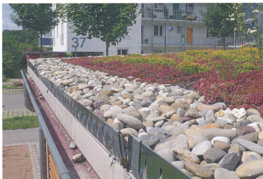
Un lit de cailloux disposé en bordure de la toiture joue le rôle de drain minéral.
