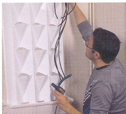
Installation du système d'irrigation.
