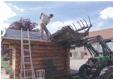
Le substrat peut être de la terre végétale déposée sur la couche d'étanchéité et la protection antiracines.
