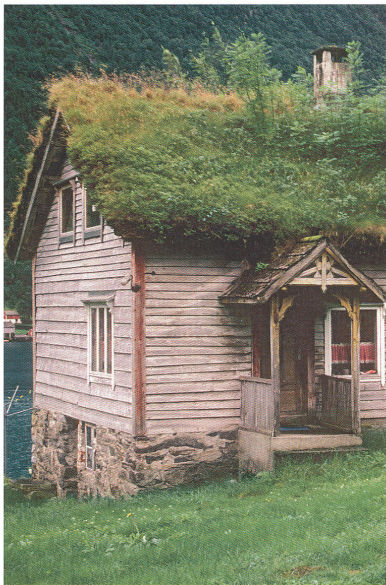
Si l'épaisseur de substrat le permet, une végétation très variée comprenant même des arbustes peut se développer sur un toit (ici en Norvège).
