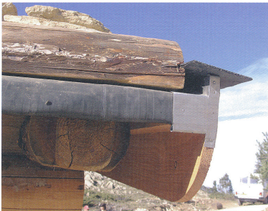
La qualité des matériaux utilisés pour l'écranchissement (ici du caoutchouc synthétique) est primordiale pour la durabilité de l'ouvrage.
