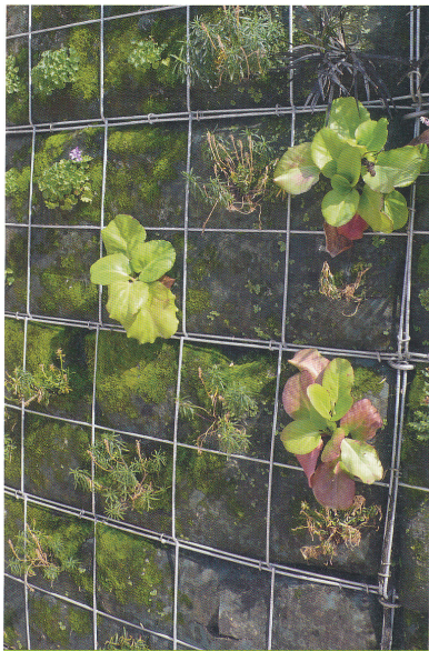
Mur végétal extérieur constitué de modules métalliques remplis de substrat et remplis.
