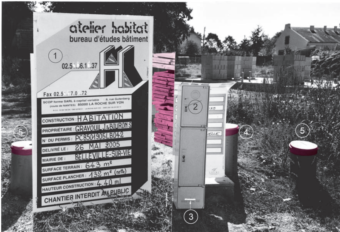
Regards sur le lotissement avec lots viabilisés : eau, coffret EDF, tabouret EU et EP, cit Télécom
