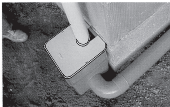
En pied de chute avec couvercle piéton.
