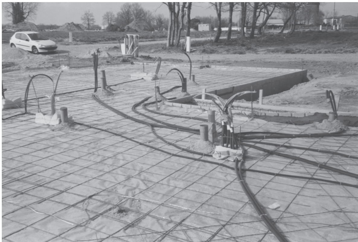
Fig. 26 : Tubes PER pré-fourreautés sur le treillis soudé de la dalle sur terre-plein et émergences enveloppées
