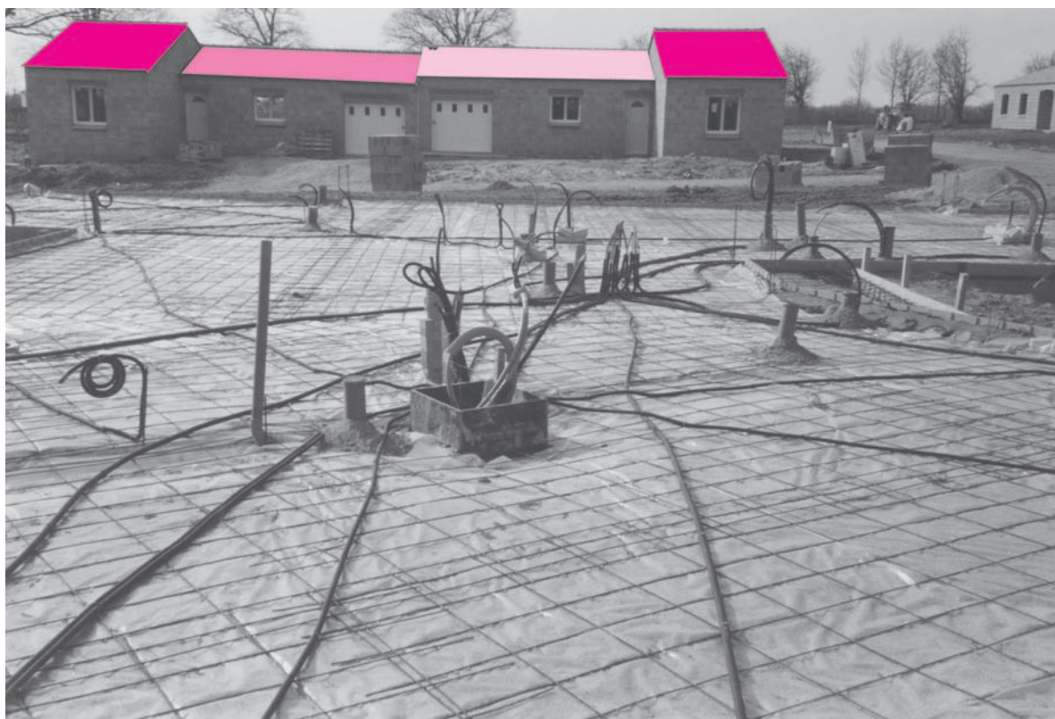
Fig. 27 : Alimentation d'appareils avec tubes PER sous fourreau et sorties dans un coffrage (caisson) pour les collecteurs
