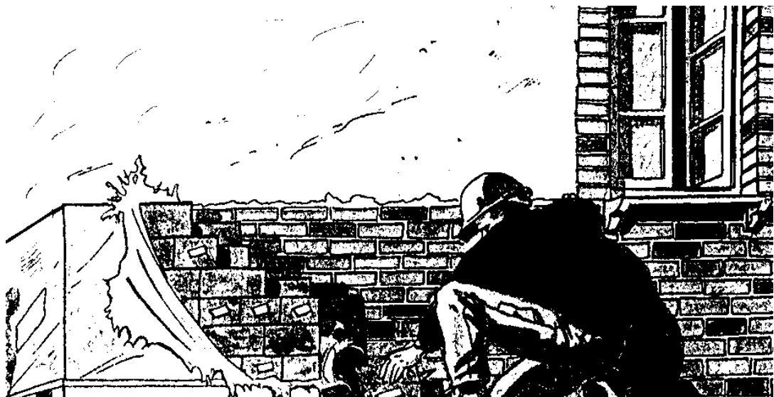
Stocker les cartons de plaquettes à l'abri des salissures et de la pluie.
