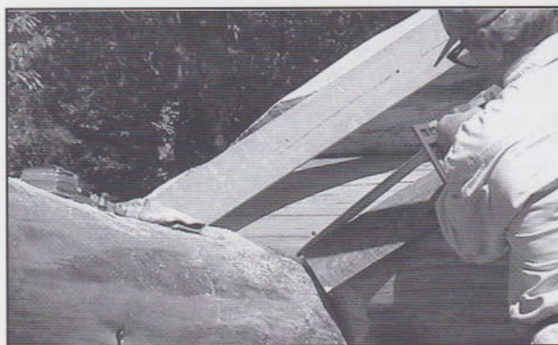
Découpe d'encastrement d'un plafond
