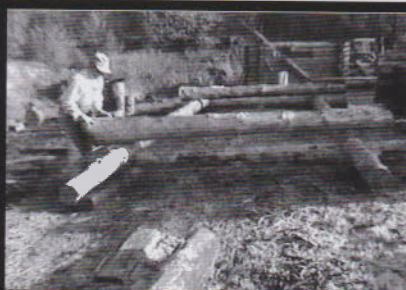
Poser le bois choisi et centrer son axe de symétrie sur l'axe du mur.
