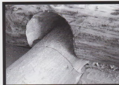
Le jeu doit être suffisant...
