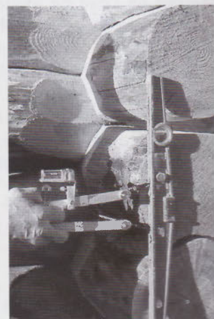
(17) Le niveau de chantier fixé par un tirefond
