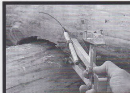
Commencer à tracer sur le sommet d'une tête. La préentaille doit être suffisamment creusée pour que la pointe sèche puisse y pénétrer.
