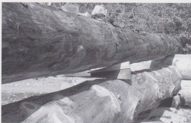
(34) Des cales pour mettre en tension des bois de longueur > 5 m.
