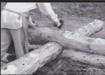
Remettre le bois en place, un dernier coup de masse pour le serrer.
