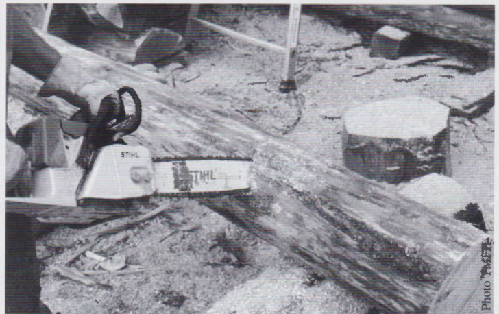
47 Découpe d'une entaille d'angle
