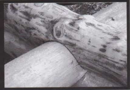
... L'aspect extérieur est semblable à la tête de chien. Plus tard, on améliorera encore cette entaille en faisant des tenons... (à suivre)
