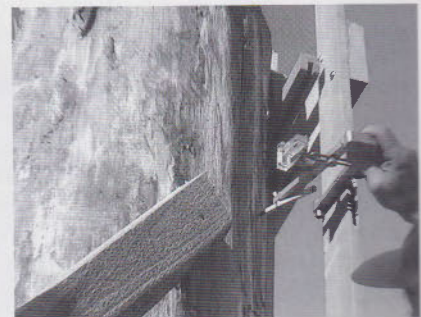
(39) Traçage d'un plan vertical sur un poteau
