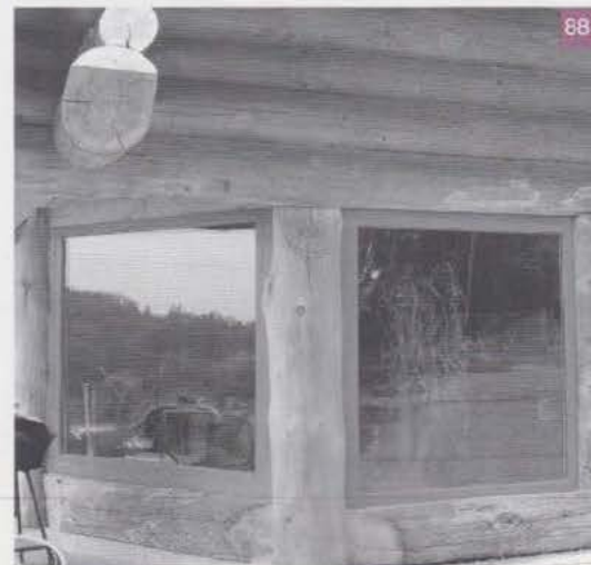
Poteau d'angle entre deux vitrages fixes
