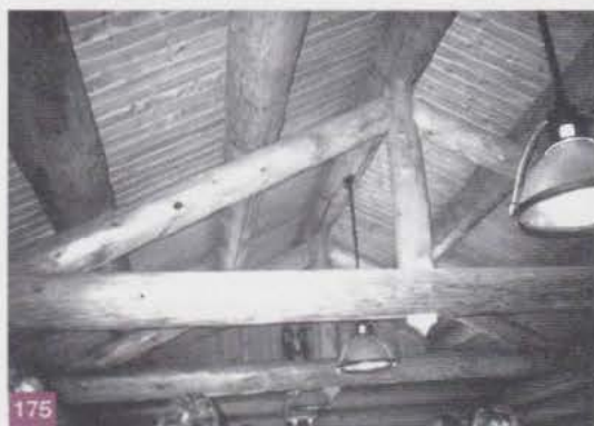
Exemple de charpente à simple poinçon - Réal. Mike Senty, Minnesota
