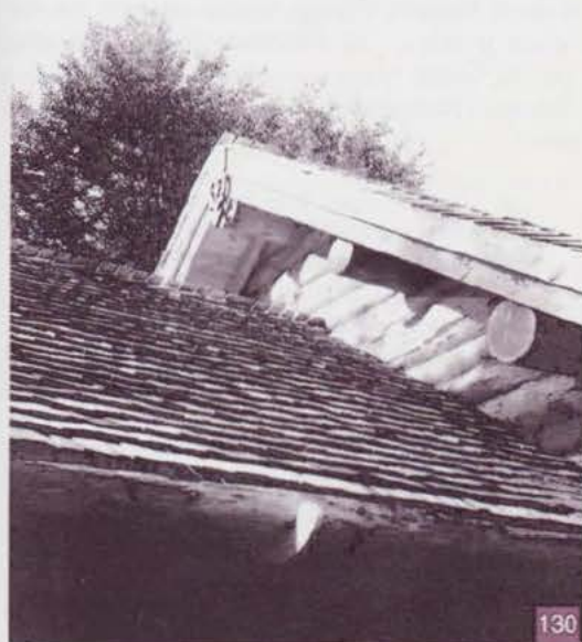
La toiture de la deuxième structure s'encastre sous celle de la première (couverture en bardeaux de châtaignier fendus)
