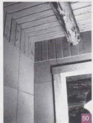
50 Frise en lambris couissant devant le parement de la cloison
