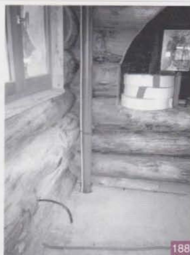
Rondins percés pour passage d'un câble RO2V qui sera gainé
