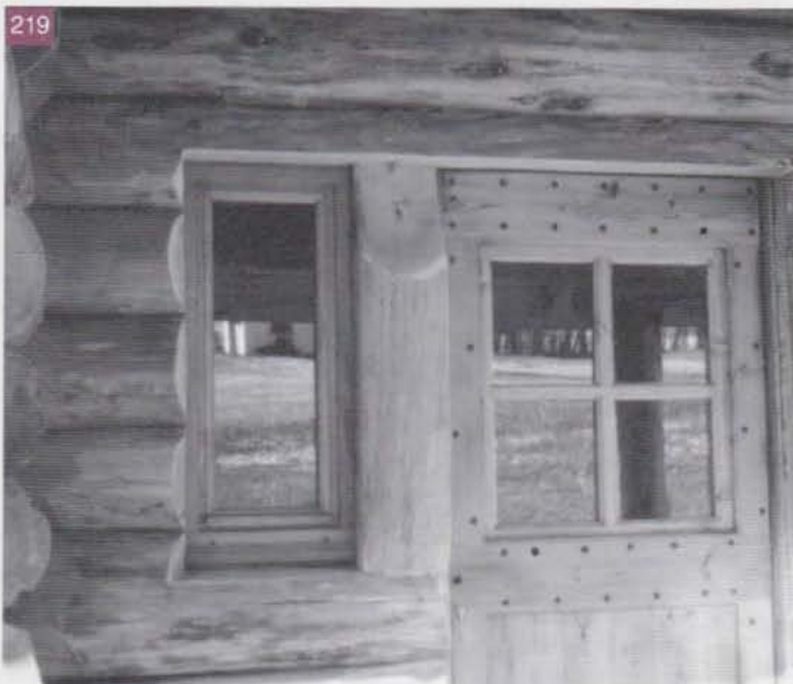
Porte et fenêtre de part et d'autre d'un poteau.
