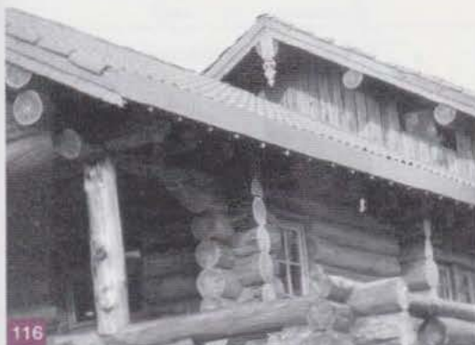
Toitures imbriquées et charpente en structure verticale.
