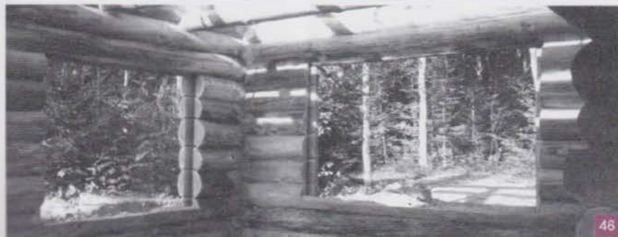
Sur ces deux fenêtres en angle, la hauteur du linteau est donnée par la ligne des rondins et non par le niveau : elle est en décalage d'un demi-tour d'un mur à l'autre (Remarquez les feuillures d'encastrement dans les montants pour méthode de pose "à la norvégienne", cf. ill. 40.2)
