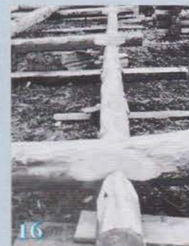
16 Le recalage et l'équerrage doivent être parfaits.
