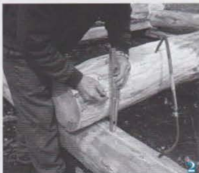
Positionner la solive : remonter cet axe au niveau.
