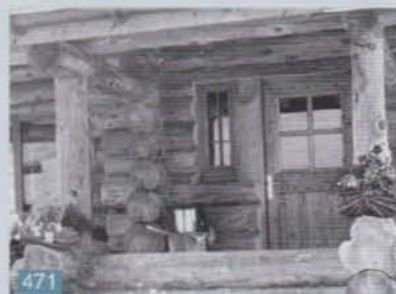
Une porte et une fenêtre peuvent être accolées de part et d'autre d'un poteau-linteau.
