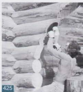
Le ponçage des arches
