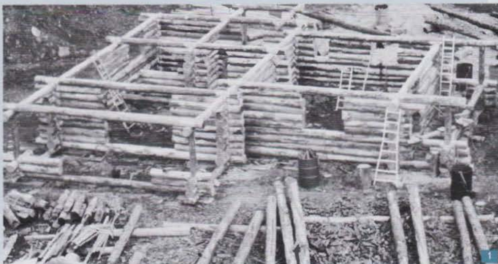
Du premier tour aux pannes sablières : la maîtrise de l'entailage et surtout du choix des bois, pour parvenir sans blocage, au sommet du mur avec des bois irréguliers et décroissants.
