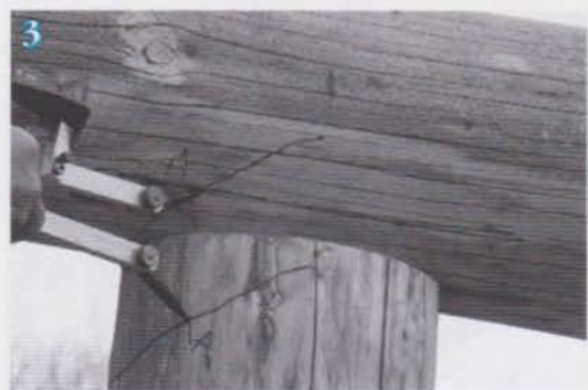
Une double ligne est tracée de part et d'autre du poteau.
