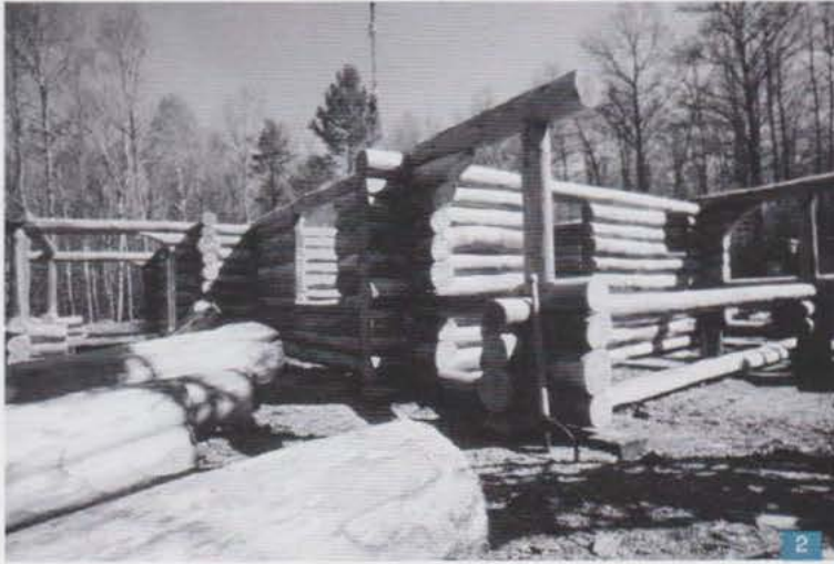
Une ossature de fuste en cours de préfabrication
