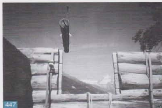
...c'est là que pourraient apparaître les décalages dus à des erreurs de calage ou d'équerrage. Sangler les bois.
