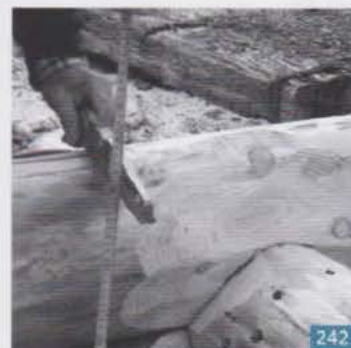
242 Mesurer le niveau par rapport à la dalle brute (le dessous du 1/2 rondin).
