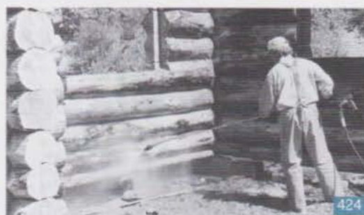
Le nettoyage à l'eau sous pression au « Kärcher »
