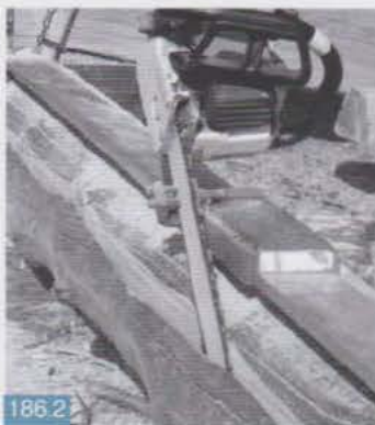
Scier en s'aidant d'un guide en U
