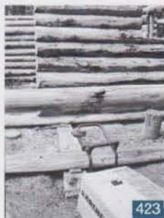
Le nettoyage à l'eau sous pression au « Kärcher »
