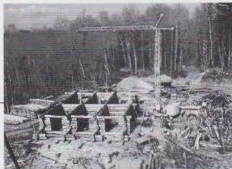
Dans une grue à montage rapide, la rotation se fait à la base: le mât et la flèche tournent ensemble. C'est la grue idéale pour le fustier.
