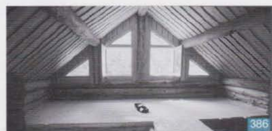
Une charpente «pannes sur poteaux» vitrée
