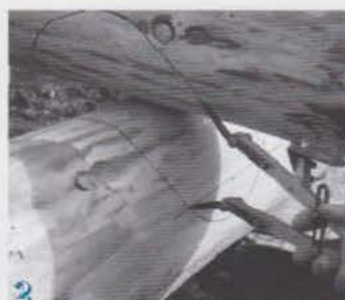
2 ...et double-tracer en reportant les points A/B/C/D.
