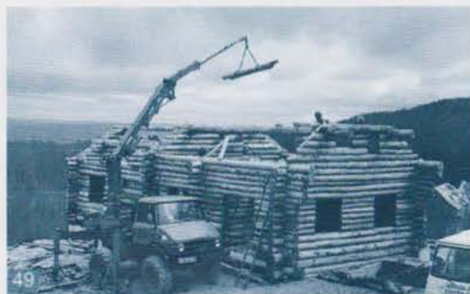
Montage avec grue hydraulique sur Unimog
