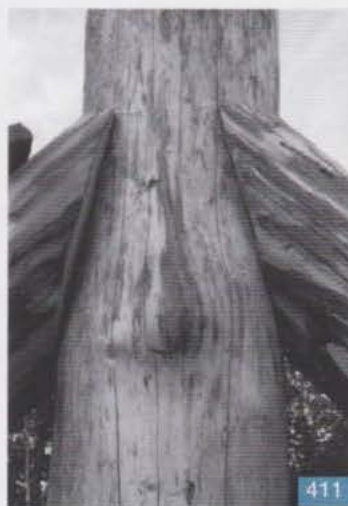
Embranchement en about en tête de poinçon (pente forte)
