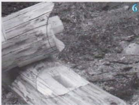
L'emboîtement du poteau «plat sur plat» renforcé par un tenon.
