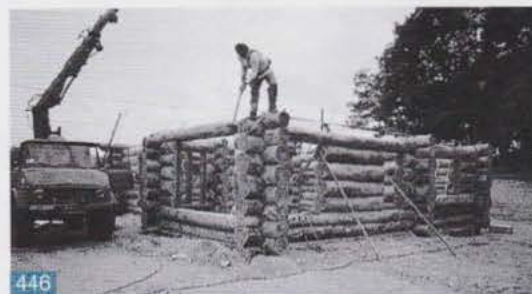
Un bon coup de masse pour mettre le linteau à sa place précise...
