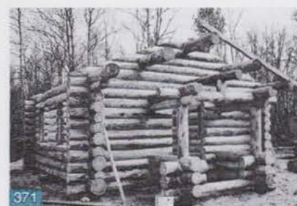
Même sur une petite construction, les pannes intermédiaires sont nécessaires.
