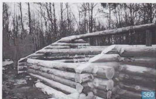
Entre la panne et la ligne de découpe du pignon, on laisse l'épaisseur du chevron
