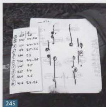
245 Reporter sur le plan les hauteurs de tête et les niveaux
