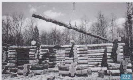
Monter un mur qui soit horizontal en son sommet, avec des billes de forme plus ou moins conique.
