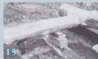
15 Pour recaler au sol avec précision, utilisez des crics ou vérins et des cales.
