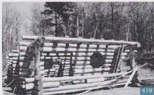
Première étape : la préfabrication /419/ Deuxième étape : le remontage /418/ Dernière étape : la maison finie /417/
