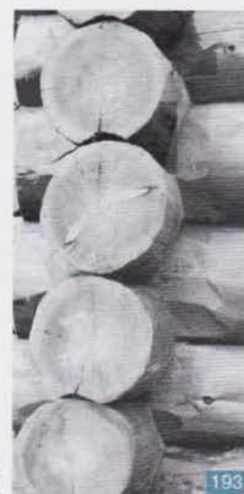
... ou quand on n'a pas laissé de jeu entre les débords (comparez bois du haut et du milieu)
