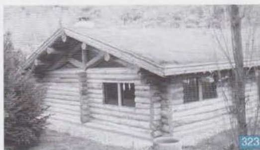
De haut en bas : charpente-pignon en rondins (d'une hauteur un peu exceptionnelle : système de coulissage indispensable), charpente-poteaux et ferme triangulée
