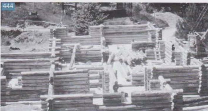
Remontage de l'ossature : on approche des linteaux, le moment critique
