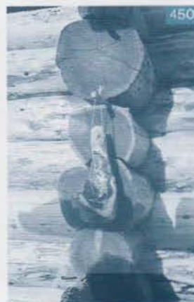
Un bon coup de masse pour mettre le linteau à sa place précise...
