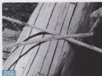
Pour faire un bon équerrage, utiliser deux décimètres...
