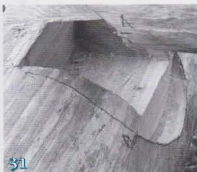
Si nécessaire, on peut aussi élargir l'épaulement.
