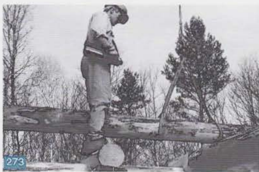
273 Bien regarder le fût pour déceler les courbures, et le mettre en bonne position, seul et aisément, grâce à la radiocommande de la grue.
