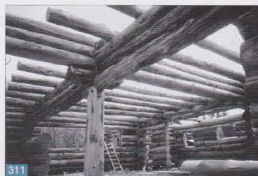
Solivage avec porte-à-faux pour mezzanine et poteau de soutien
