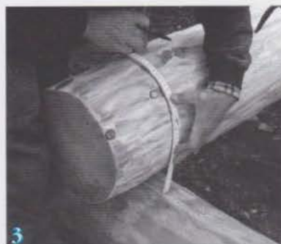
Tracer le contour à découper.
