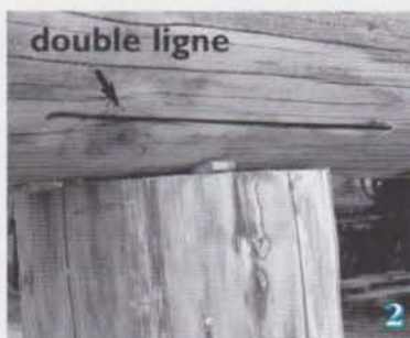
Une double ligne est tracée de part et d'autre du poteau.
