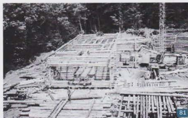
La grue, l'ossature en construction et le stock de bois triés
