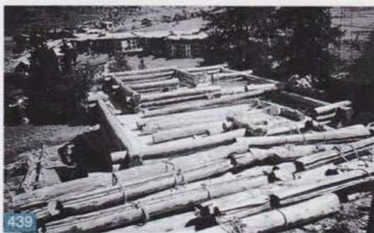
439 Remontage des premiers tours : en zone de montagne, il n'y a pas toujours beaucoup de place pour ranger les bois.
