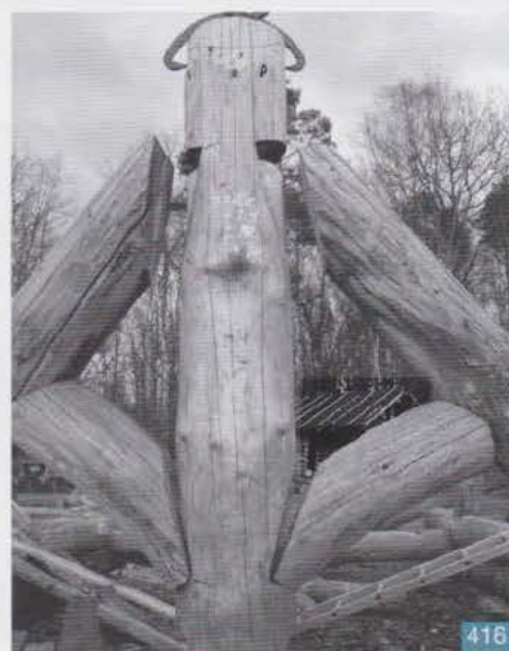
L'assemblage de la ferme
