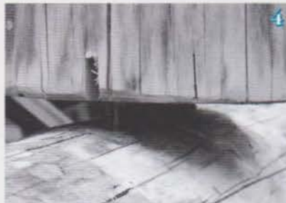
Un contreplaqué de 12 mm facilite la mise en place du poteau pour le traçage sur la lisse
