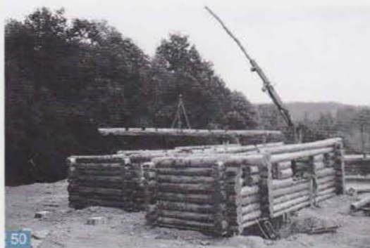
Montage avec grue hydraulique sur Unimog
