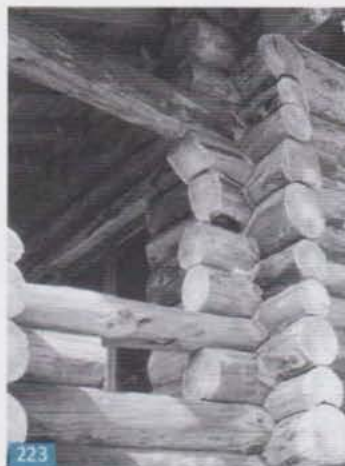
Alterner gros bout et petit bout, tout en préservant l'harmonie des diamètres.
