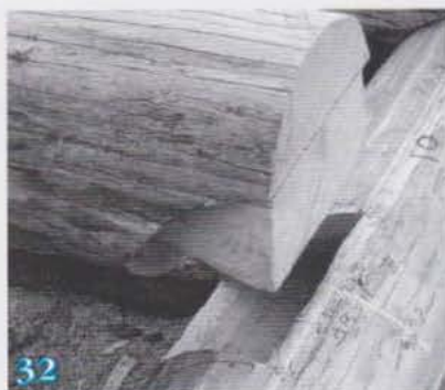
Le jeu doit être minime.
