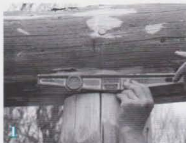
Définir et tracer 2 lignes horizontales de part et d'autre de la panne.
