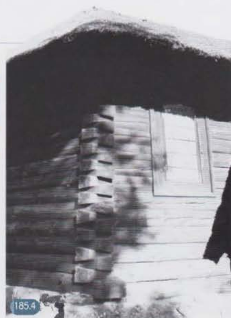
Une entaille traditionnelle de l'Europe (ici en Pologne)
