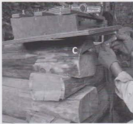
Traçage sur le bois inférieur
