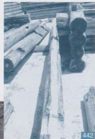
Le fût entaillé, rempli d'isolant, est prêt à être posé
