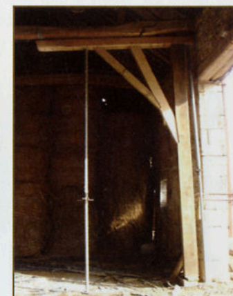
2. L'entrain repose sur une forte pièce de bois fixée à une poutre confortée par des aisseliers. Il va être boulonné à cet ouvrage de soutien ; le Tirfor® pourra ensuite être retiré.
