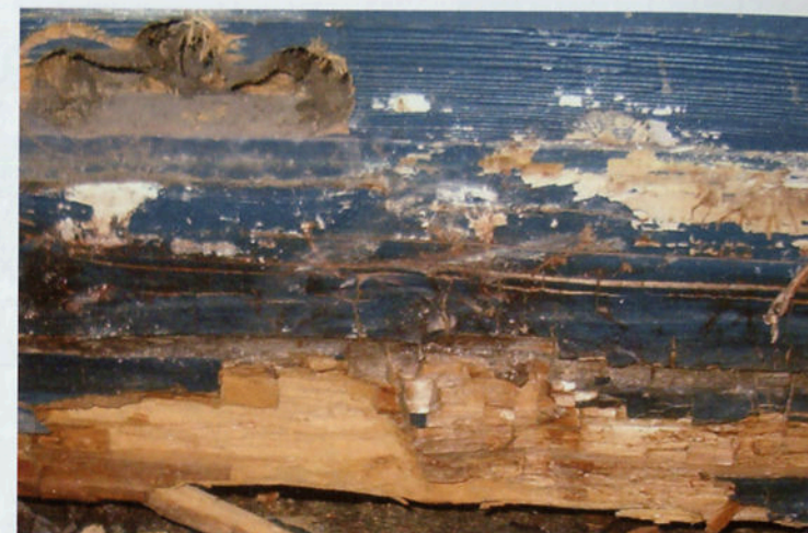
La pièce de bois attaquée par le méréle se désagrège sous la forme d'une « pourriture cubique » caractéristique.
