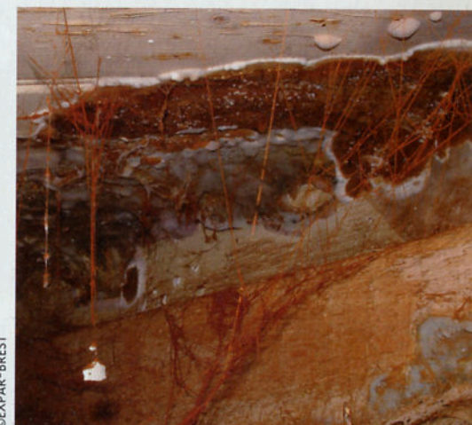
La pièce de bois attaquée par le méréle se désagrège sous la forme d'une « pourriture cubique » caractéristique.
