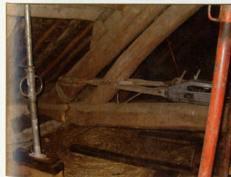
1. Un Tirfor® est utilisé pour «ramener» au plus près les deux éléments de l'entrain rompu.
