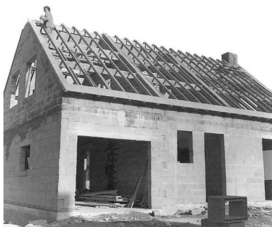
Vue n° 3 : pavillon à combles aménageables ; charpente : pannes avec appuis sur pignons extérieurs et intermédiaires Éclairage des combles : fenêtres en pignons extérieurs.
