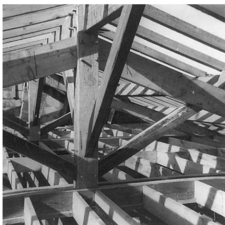
Vue n° 5 : détail d'une ferme porteuse de la charpente et du faux solivage pour le plafond Toiture à faible pente (33 %). Combles perdus.
