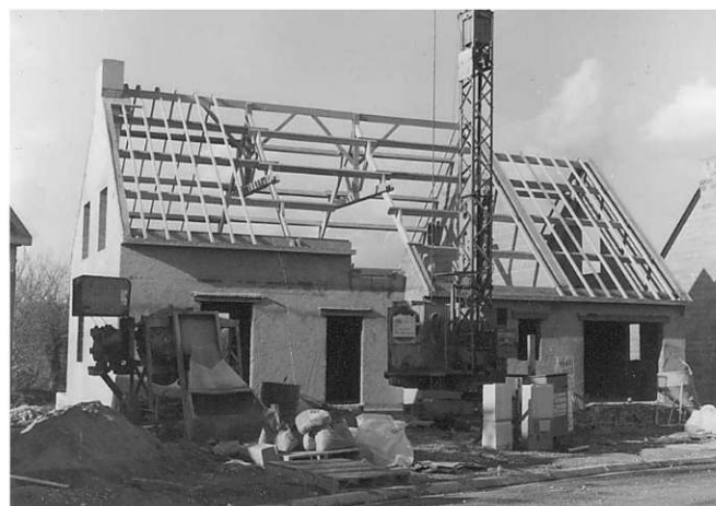
Vue n° 6 : charpente avec fermes à entrain retourné pour combles aménagés Appuis des fermes sur les murs de façade et le plancher en béton armé. Éclairage des combles : fenêtres en pignon + « vélux » éventuels.
