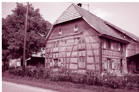
Maison du Sundgau, en Alsace. Dans cette région le pan de bois est avant tout marqué par le jeu des lisses structurant horizontalement des panneaux barrés par des décharges rarement rectilignes.
