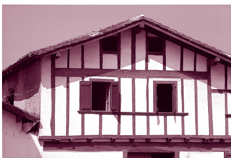
Maison du Labourd, en Pays Basque. Le pan de bois y est très sobre, sans décor, et les poteaux de remplissage très espacés et de faible section.
