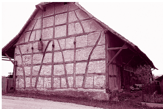
Sur ce pignon du Sundgau, en Alsace, les pièces de décharge s'opposent d'un panneau à l'autre en composant un véritable décor.
