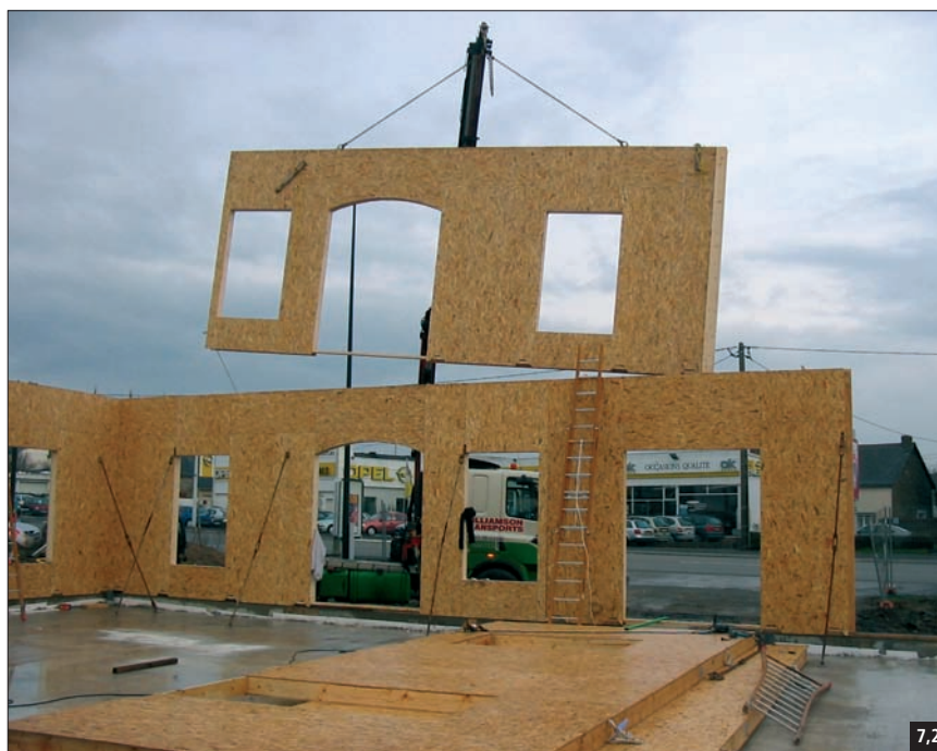
Fig. 7.2 La construction par grands panneaux est le procédé le plus utilisé en France.
