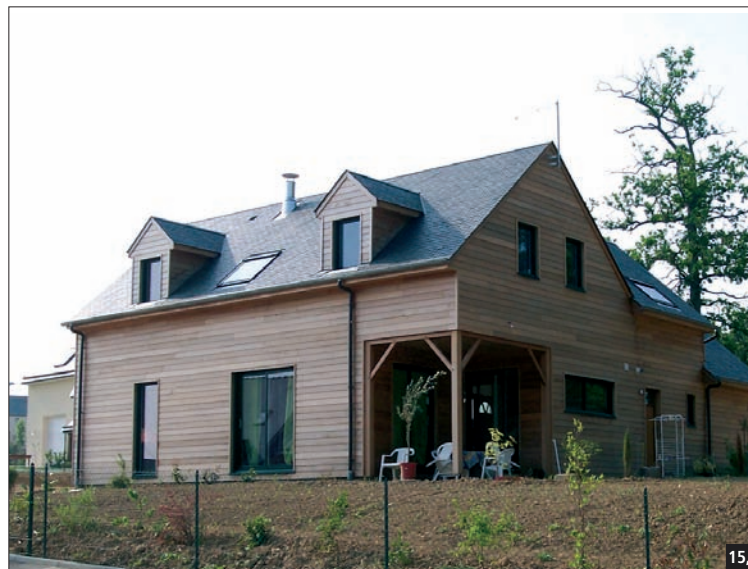
Figure 15,9 Cette maison à ossature bois nécessite 20 m 3 de bois environ, soit 10 000 kg de bois qui ont fixé 5 000 Kg de gaz carbonique.
