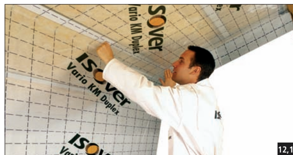
Fig. 12,10 Les plaques sont posées perpendiculairement à l'ossature secondaire car leur résistance mécanique est supérieure dans le sens de la longueur.
