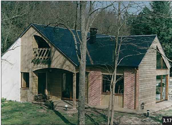
Fig. 3,17 L'association de revêtement mural en briques maçonnées, en crêpis et en lames de bardage verticales et horizontales apportent de grandes possibilités architecturales.
