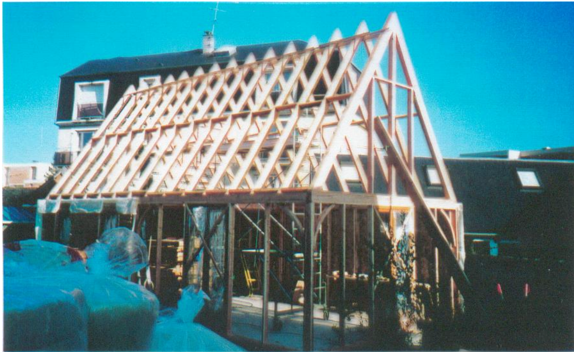
Vue d'ensemble d'une charpente en fermettes.
