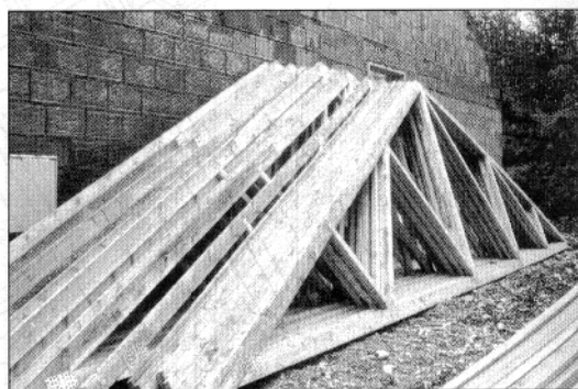
Photo 11.13 • Charpente industrialisée : fermettes WW.
