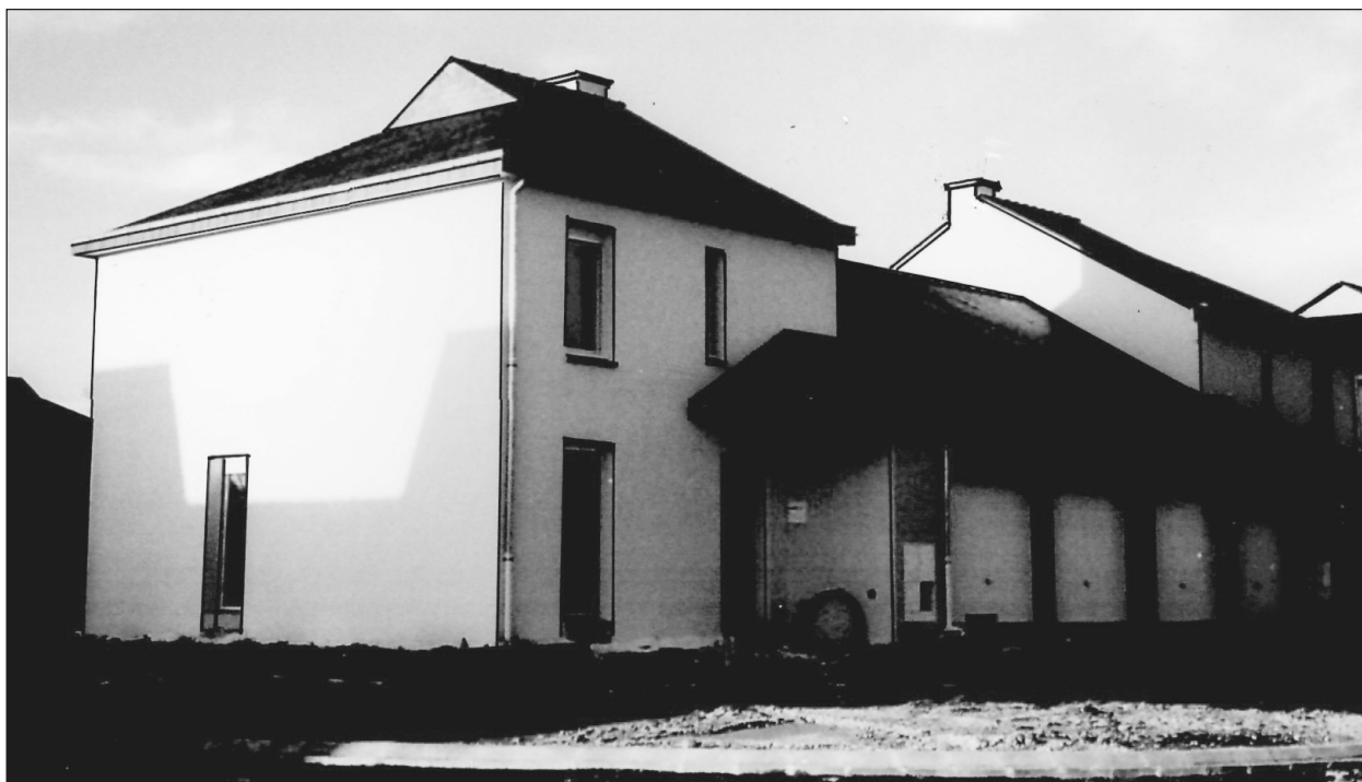
Photo 2 : Couverture en ardoises naturelles et enduit extérieur de technique monocouche
