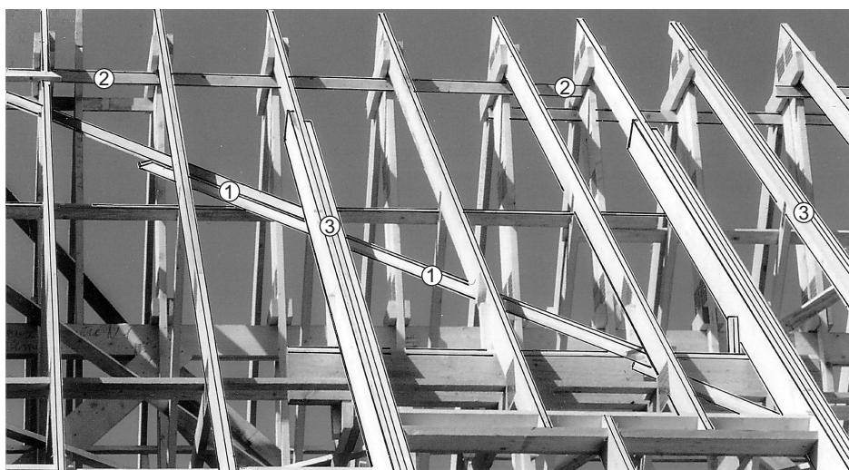
Vue C : Dispositif antflambement
