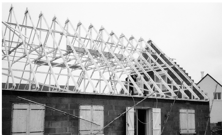
Photo 2 : Fermettes à entrait retroussé
