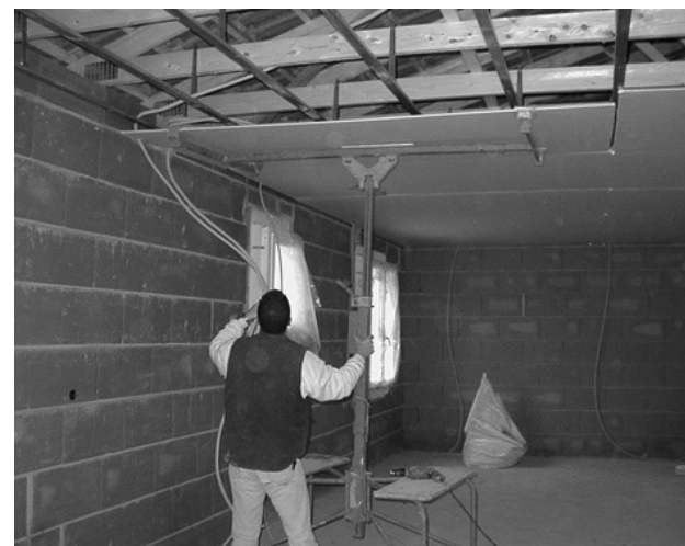
Fig. 113 Pose des plaques de plâtre à l'aide d'un lève-plaque
