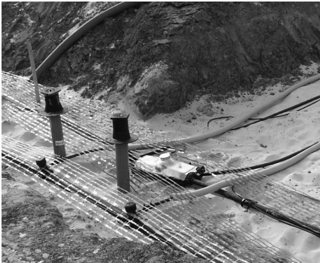
Fig. 5 Tranchée commune (eau, électricité, gaz, grillages avertisseurs, etc.) en cours de réalisation
