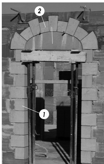
Fig. 4 Encadrement de baie en pierre de taille 1. jambage, 2. lintheau en anse de panier, 3. lintheau droit, 4. génoise
