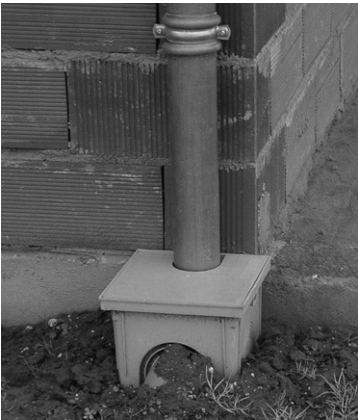
Fig. 99 Descente et regard d’eaux pluviales
