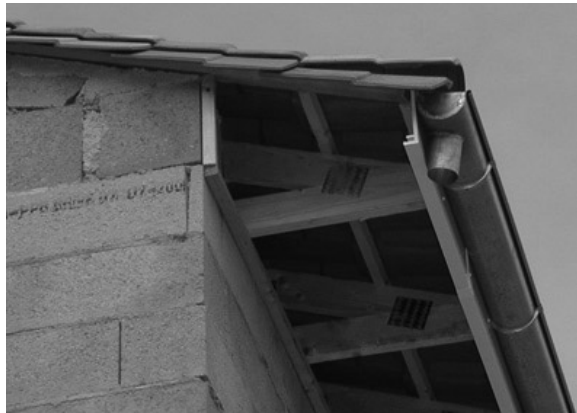
Fig. 90 Avant-toit avant la pose du lambris en sous-face
