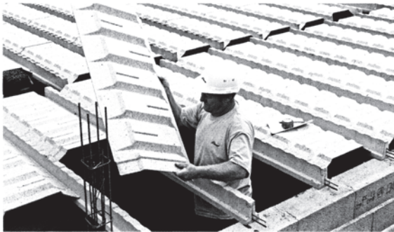
Fig. 20 : Pose d'entrevous entre poutrelles
