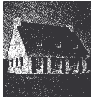
⑧ Enduits sur façades
