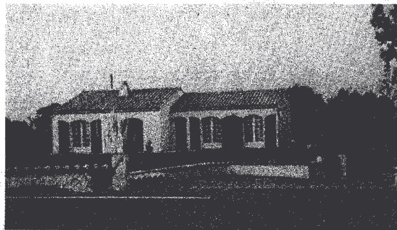
⑥ Façade d'un pavillon avec son mur de clôture
