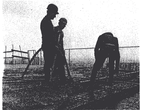
② Bétonnage par vibration à l'aiguille
