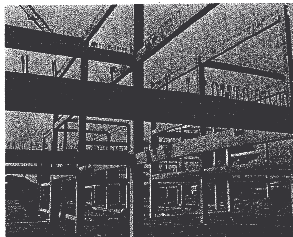
② Ossature en béton armé (poteaux-poutres)
