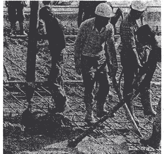
Mise en place du béton par pompage et vibration
