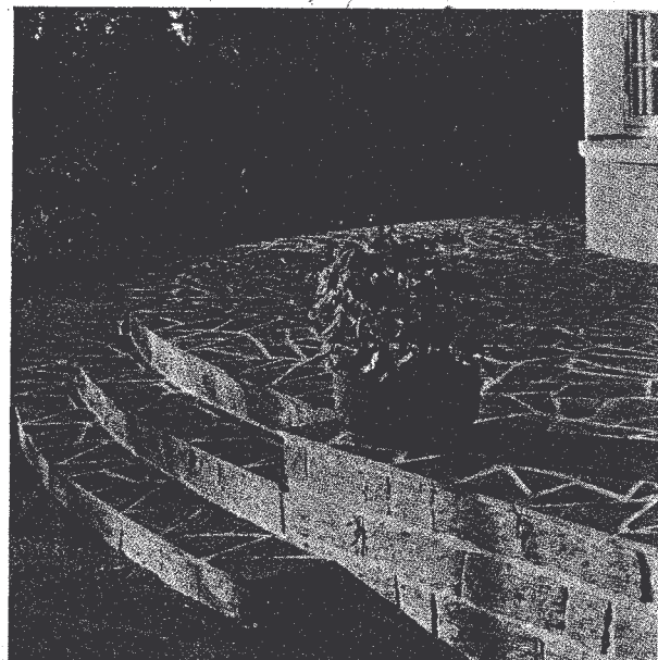
⑲ Exemple de revêtements de dallages
