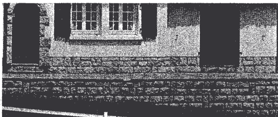
⑦ Soubassement réalisé en pierres apparentes. Au premier plan : muret qui limite une terrasse
