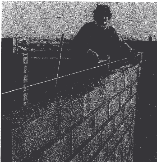
⑫ Mise en place des blocs béton - Pose à la truelle, - Alignement au cordeau.
